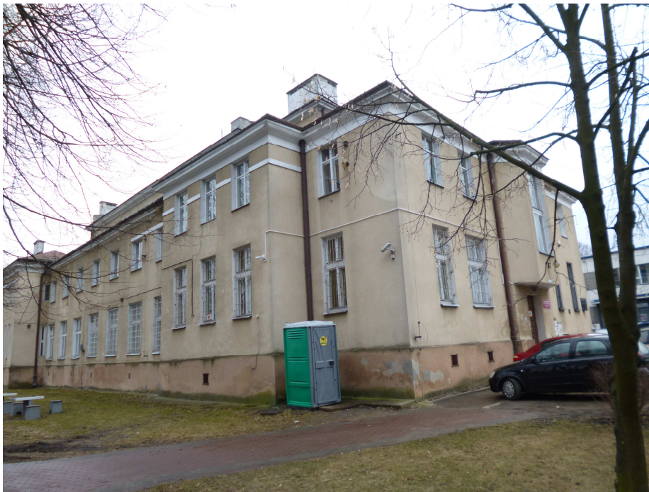
Fot. 2 – Widok ogólny budynku (1).
