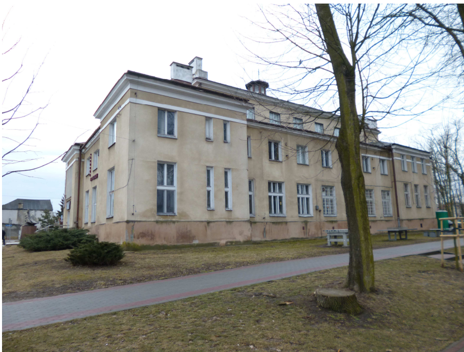
Fot. 3 – Widok ogólny budynku (2).
