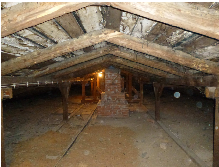
Fot. 7 – Więźba dachowa.
