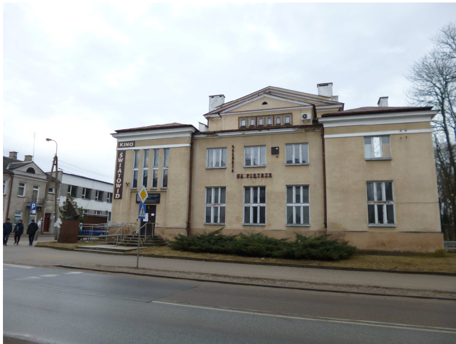
Fot. 4 – Widok ogólny budynku (3).
