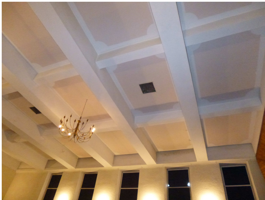
Fot. 5 – Żelbetowy strop nad piętrem.
